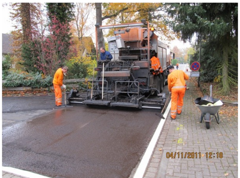
Dünne Schichten im Kalteinbau
