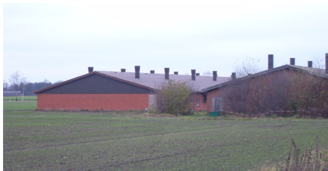
Anlage zur Mastschweinhaltung bei Klein Hehlen
