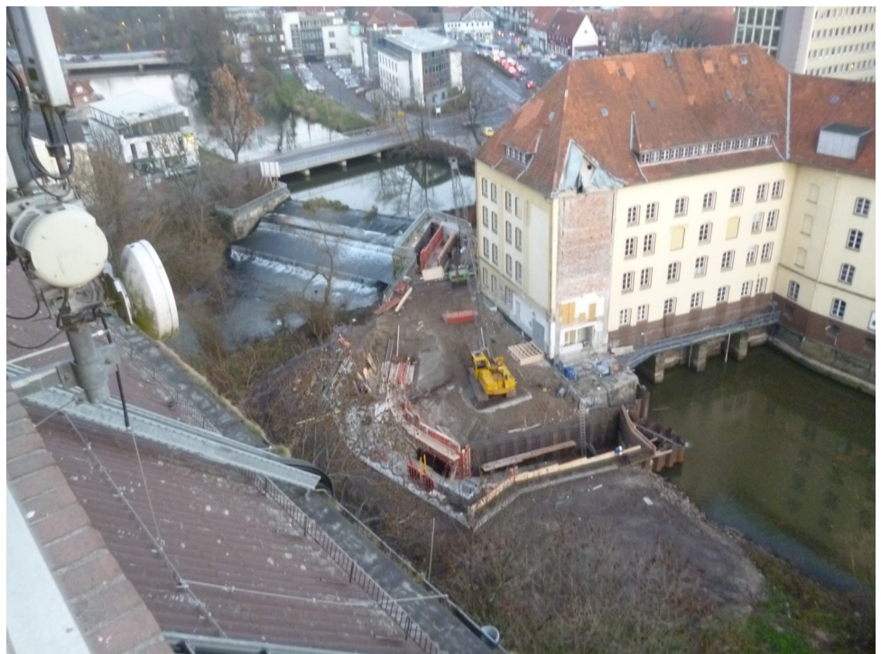
Abb. 6: Bau der Fischaufstiegs- und Fischabstiegsanlage Rathsmühle
