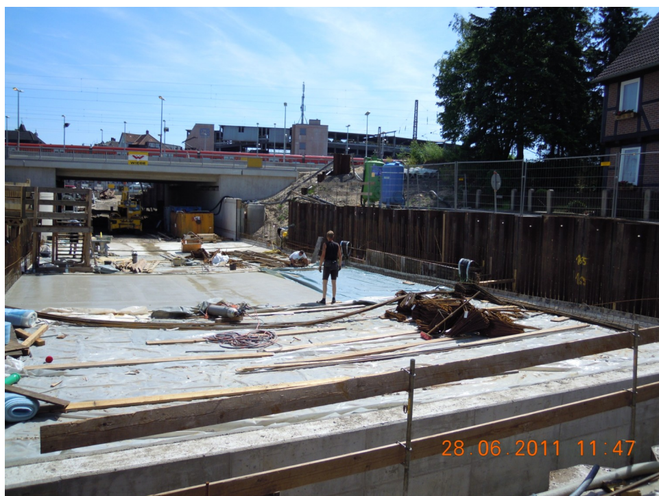
Abb. 1: Arbeiten im Bereich der Eisenbahnüberführung
