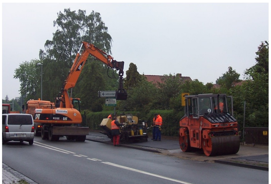
Radwegsanierung Georg- Wilhelm Straße
