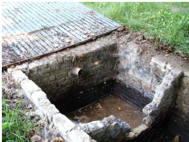
Baulicher Zustand einer Abwassersammel- grube im Bereich der Siedlung Waldkater
